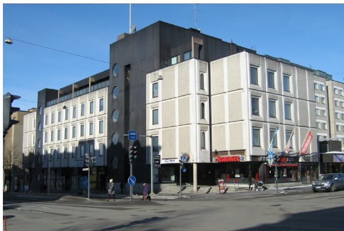
Kuva 2. Suunnittelualueella oleva vuonna 1976 rakennettu, arkkitehti Kosti Kurosen suunnittelema, alun perin Suomen työväen Säästöpankiksi suunniteltu rakennus. Rakennus on toiminut vuodesta 1997 lähtien opiskelija-asuntoina. Kuva: Neva Arkkitehdit 2019.
