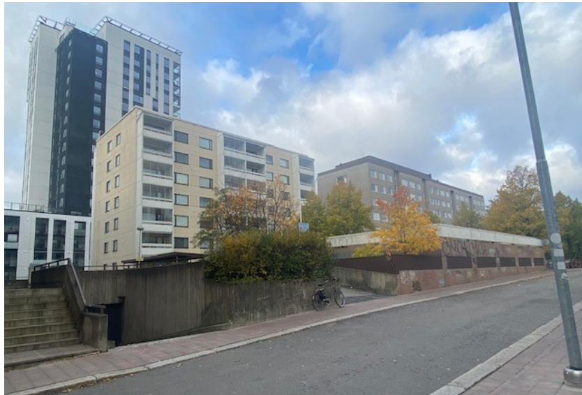
Kuva 4. 1970-luvun kerrostaloja naapurustossa Pinninkadulla. Vuonna 2018 rakennettu Luminary (suun. BST-arkkitehdit ja A-Insinöörit) edustaa uutta aikaa Tammelassa. Kuva: Sanna Lahti, 2023.
